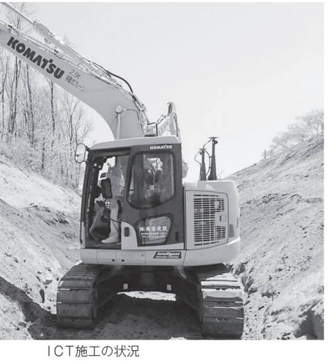
ICT施工の状況
