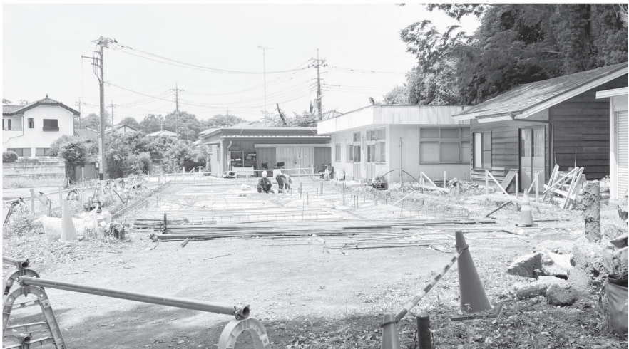
BIM活用工事の現場
