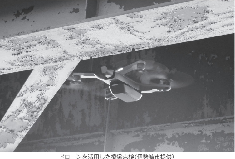
ドローンを活用した橋梁点検(伊勢崎市提供)
